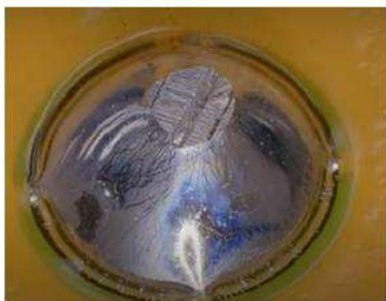
5. 납땜 후 리드 절단. 나중에 납땜 플럭스가 일어나는 위험
